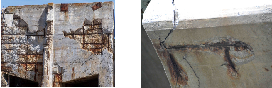
Hình 1. Bê tông cốt thép chịu tác động của ion clo [2]
