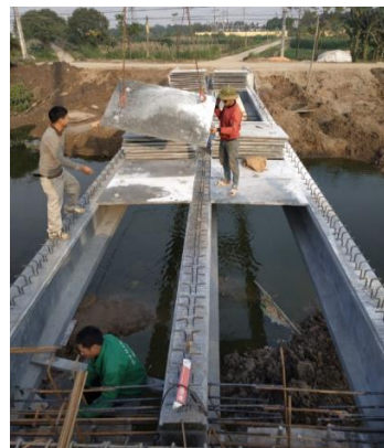
Hình 13. Thi công cầu lắp tấm ván khuôn UHPC tại công trường cầu An Thượng
